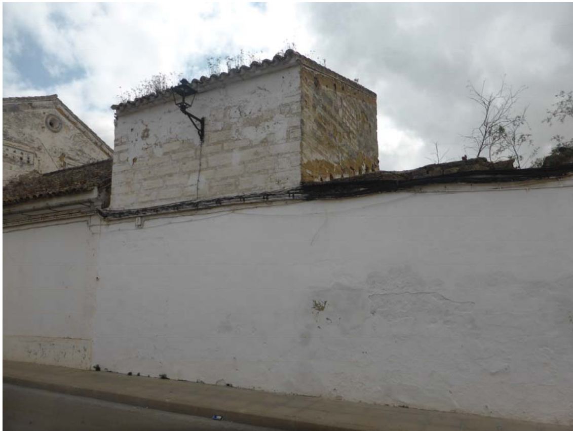
Fotografía n°2.- Vista general de la fachada a calle Olivillos (lado izquierdo, construcción colindante)
