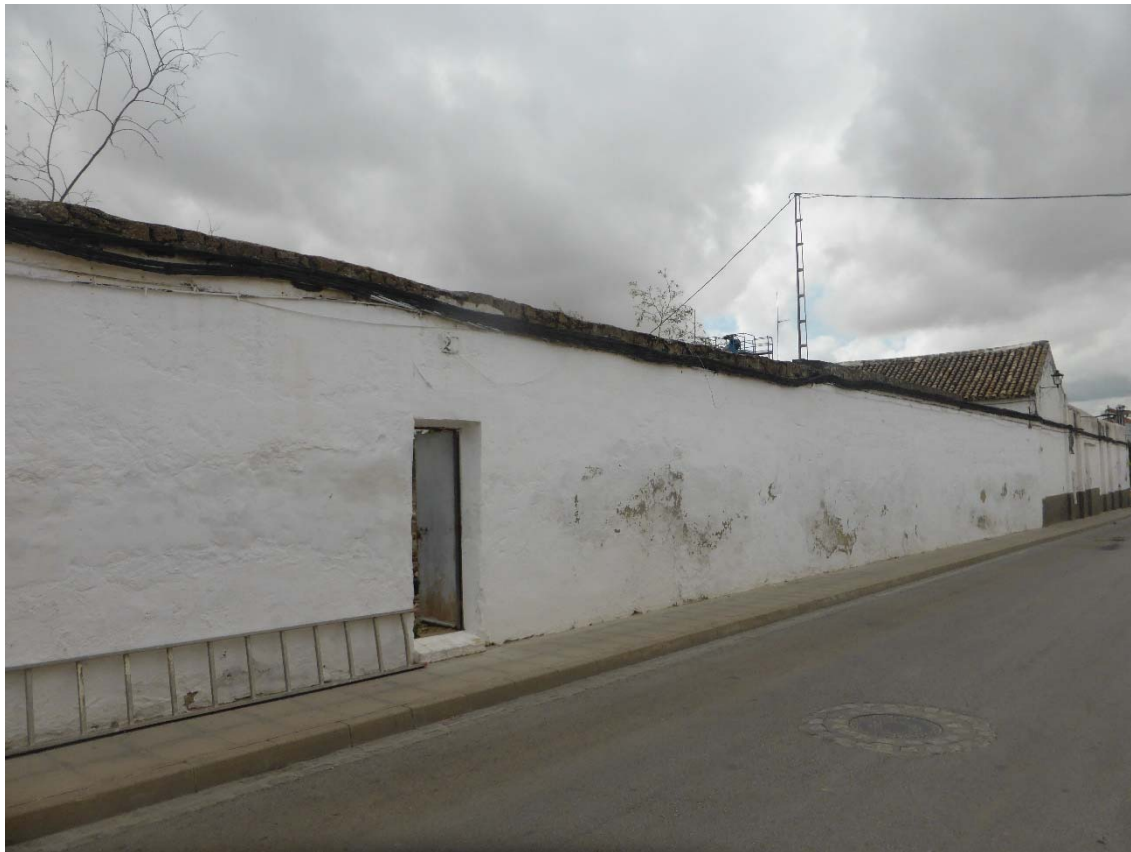
Fotografía n°1.- Vista general de la fachada a calle Olivillos (lado derecho)
