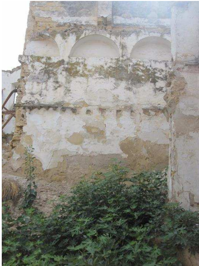
7.- RESTOS NAVE ADOSADA LATERALMENTE A C/ CARMEN Nº 25
