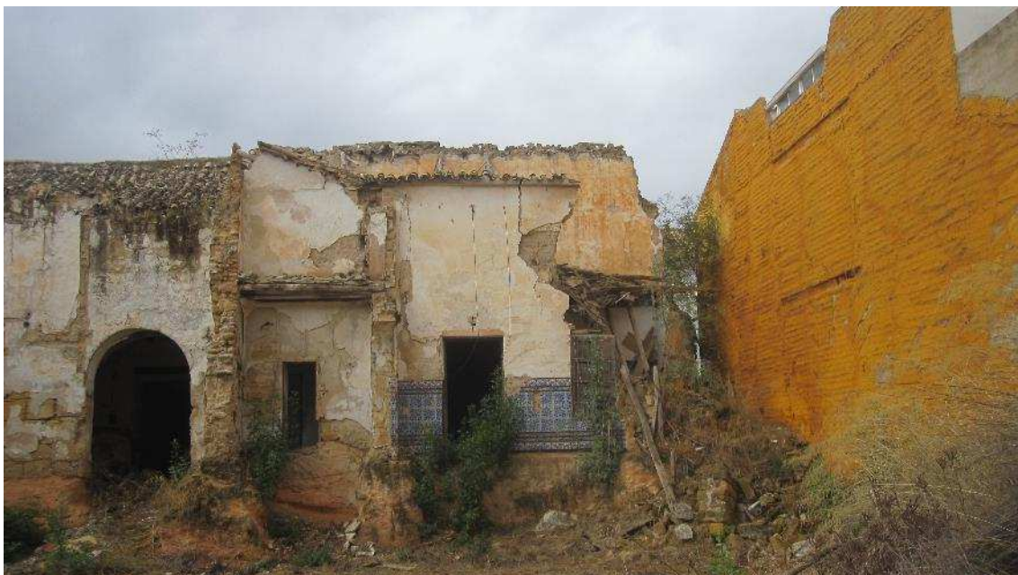
18.- VISTA INTERIOR RESTOS PRIMERAS CRUJÍAS
