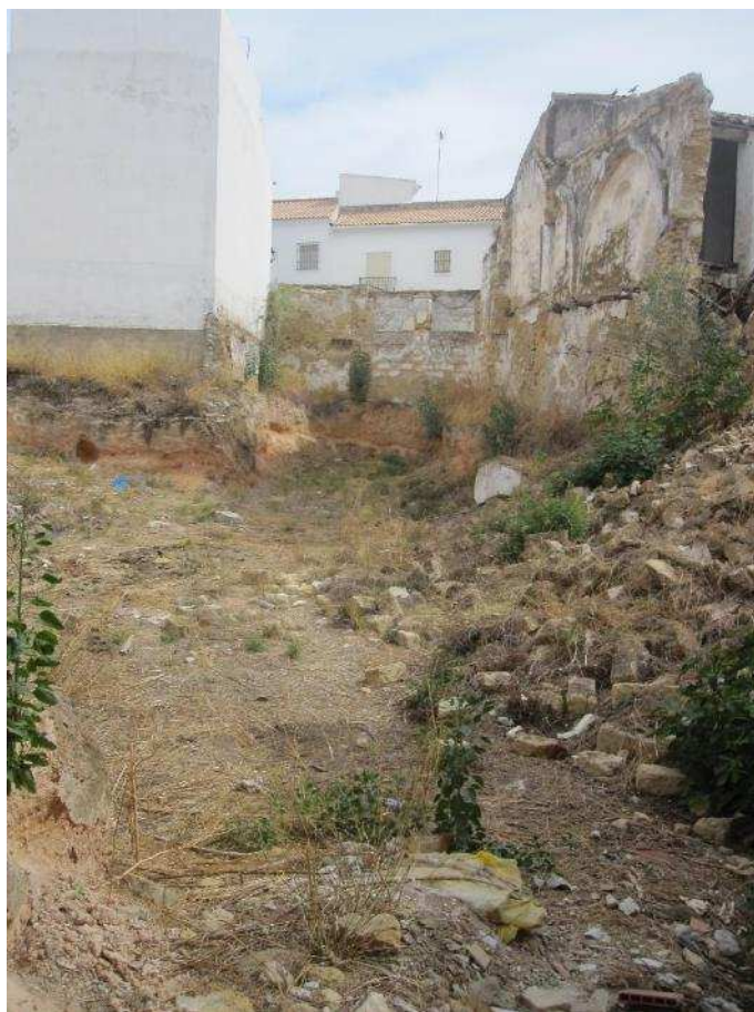
2.- VISTA GENERAL ESTADO ACTUAL C/ CARMEN 23
