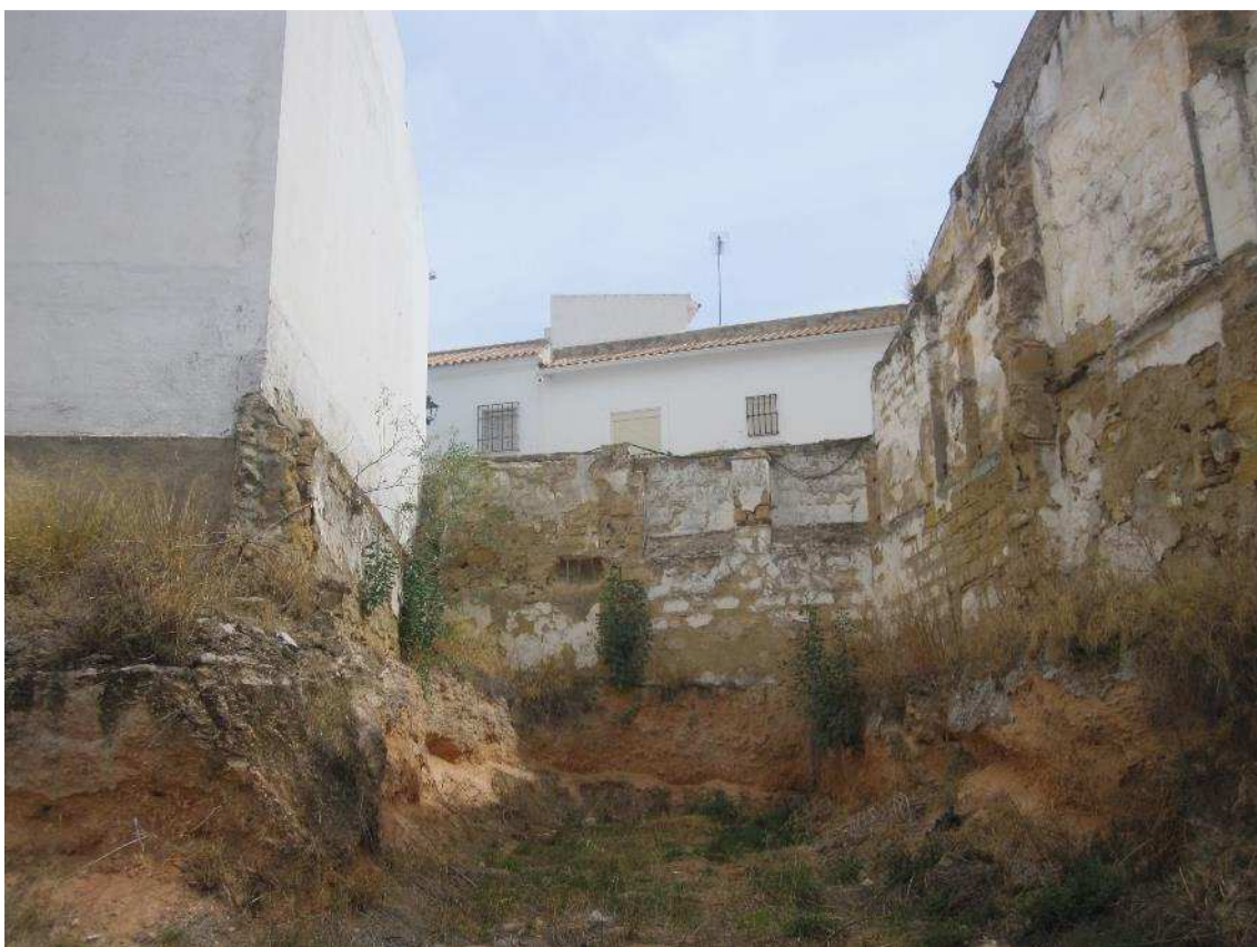
10.- FACHADA TRASERA A C/ HAZUELAS Y RESTOS DE MUROS EDIFICACIÓN A DICHA CALLE
