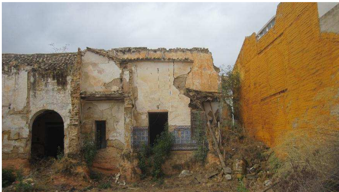
18.- VISTA INTERIOR RESTOS PRIMERAS CRUJÍAS
