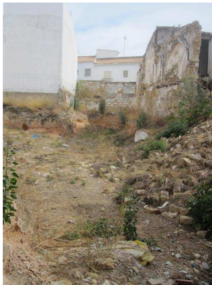
2.- VISTA GENERAL ESTADO ACTUAL C/ CARMEN 23
