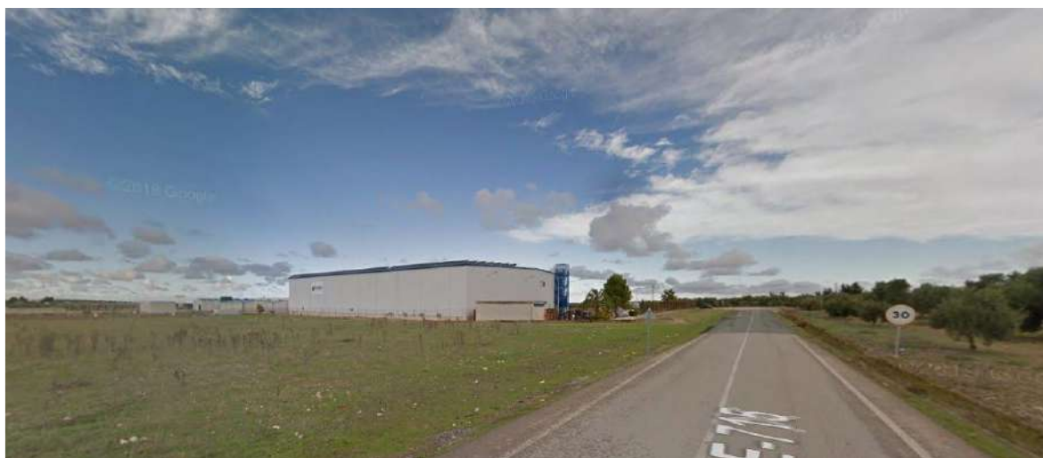
Figura 42. Fotografía detalle de la vía SE-715. Fuente: Google StreetView
