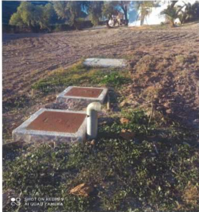
Situación de la de la fosa séptica con cámara de decantación y registro de limpieza en la fachada trasera de la casa rural.
