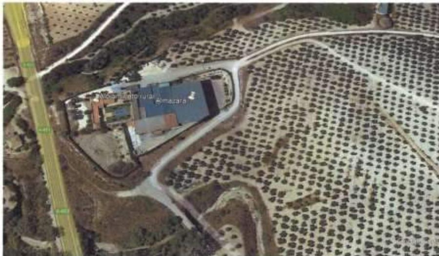
Imagen: Enplazamiento de la instalación
